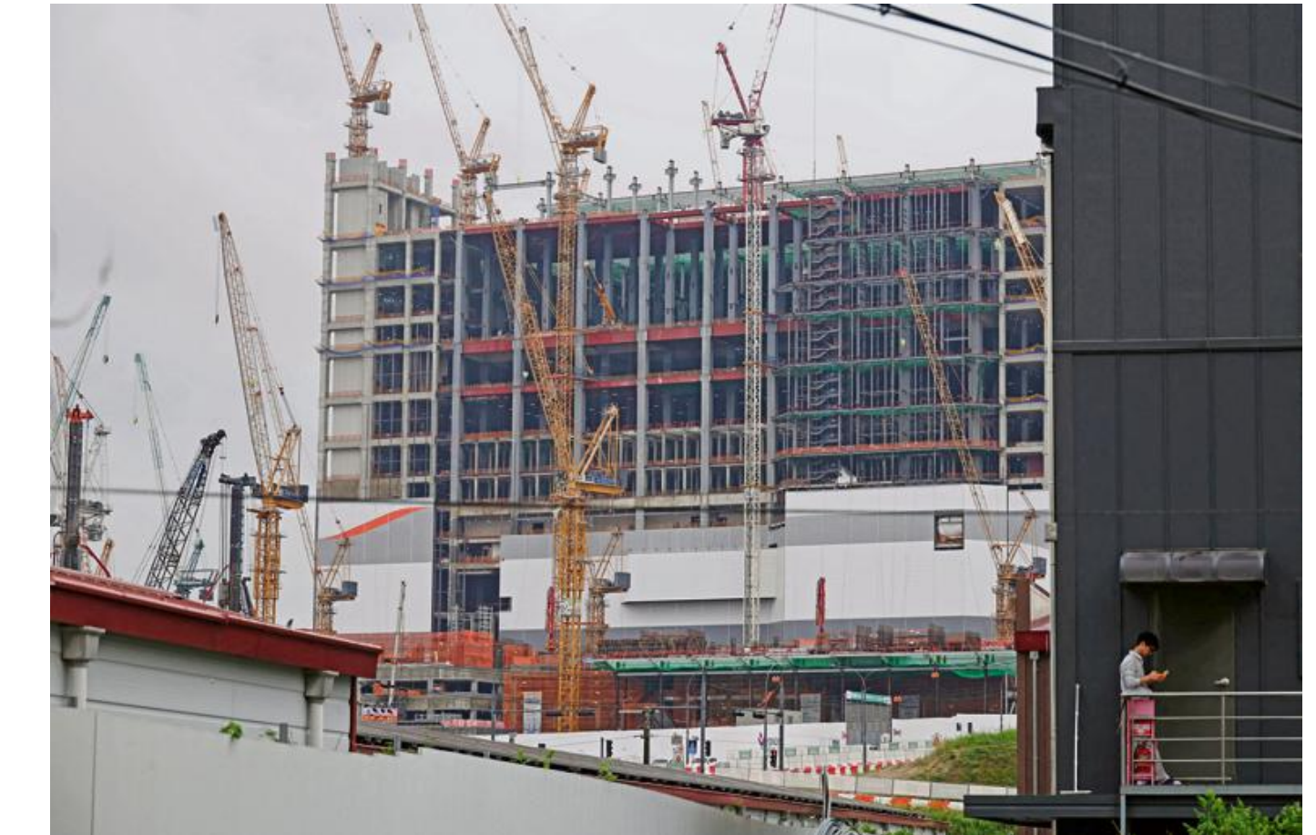
Construction d'un site de production de semi-conducteurs, à Yongin, en Corée du Sud, le 21 juillet. KIM HONG-JI/REUTERS
