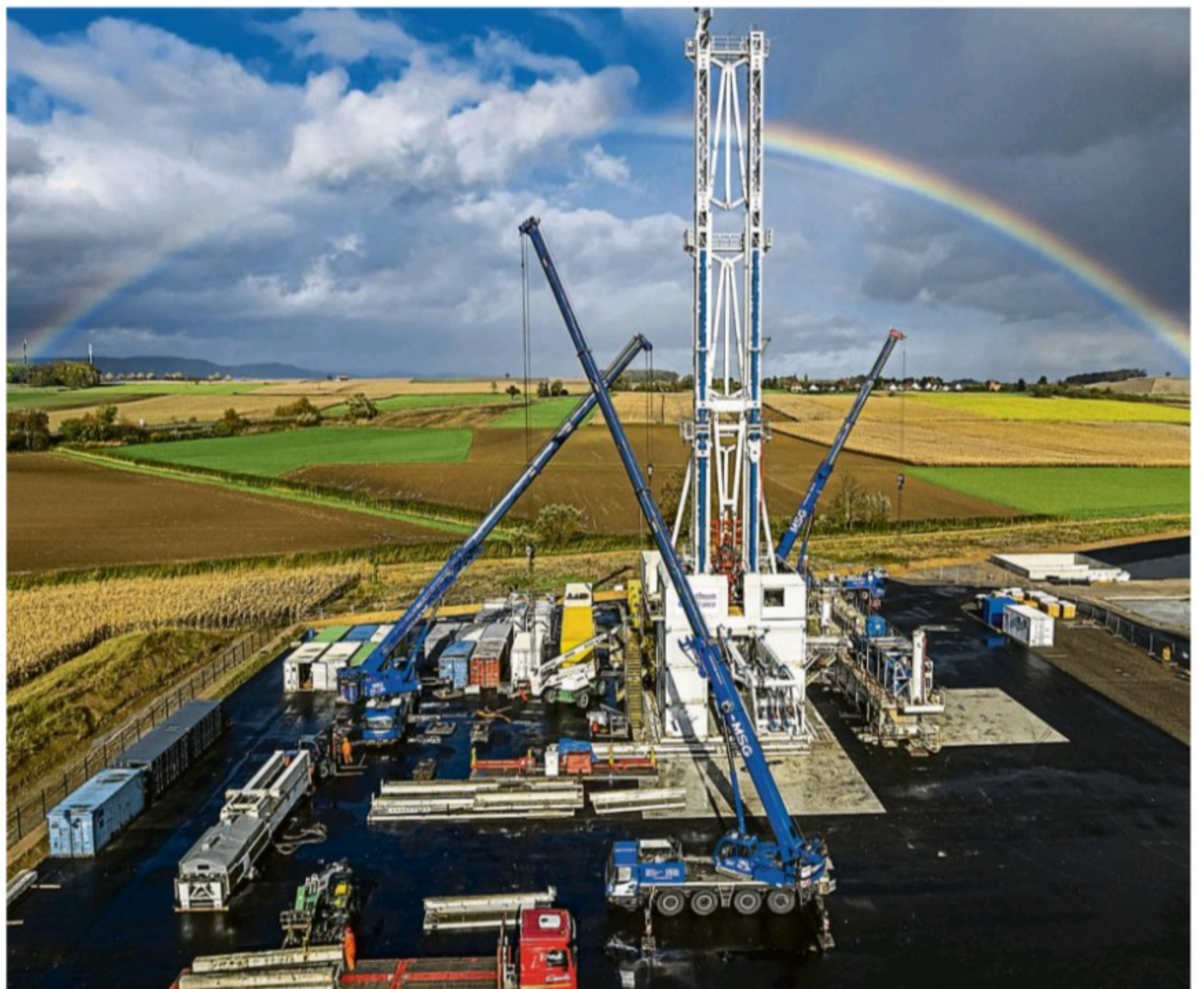
Lithium de France creuse à 2.700 mètres sous terre au lieu-dit Schwabwiller, sur la commune de Betschdorf (Bas-Rhin), pour exploiter les eaux géothermales profondes. Photo Thomas Goisque
