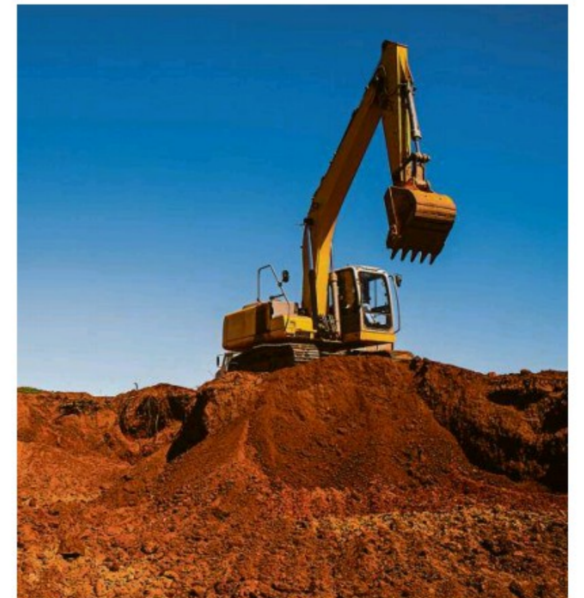
Défendu depuis plusieurs années et officiellement lancé en 2019, ce programme ne verra pas les travaux commencer avant 2026. Photo Getty Images
