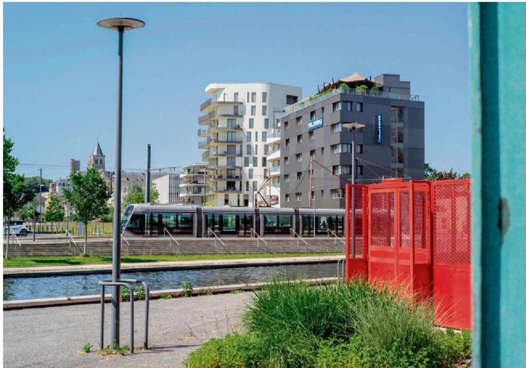
Aménagement d'un nouveau quartier sur l'ancien site industriel-portuaire de la presqu'île de Caen, le 27 mai. RAFAEL YAGHOBZADEH POUR « LE MONDE »
