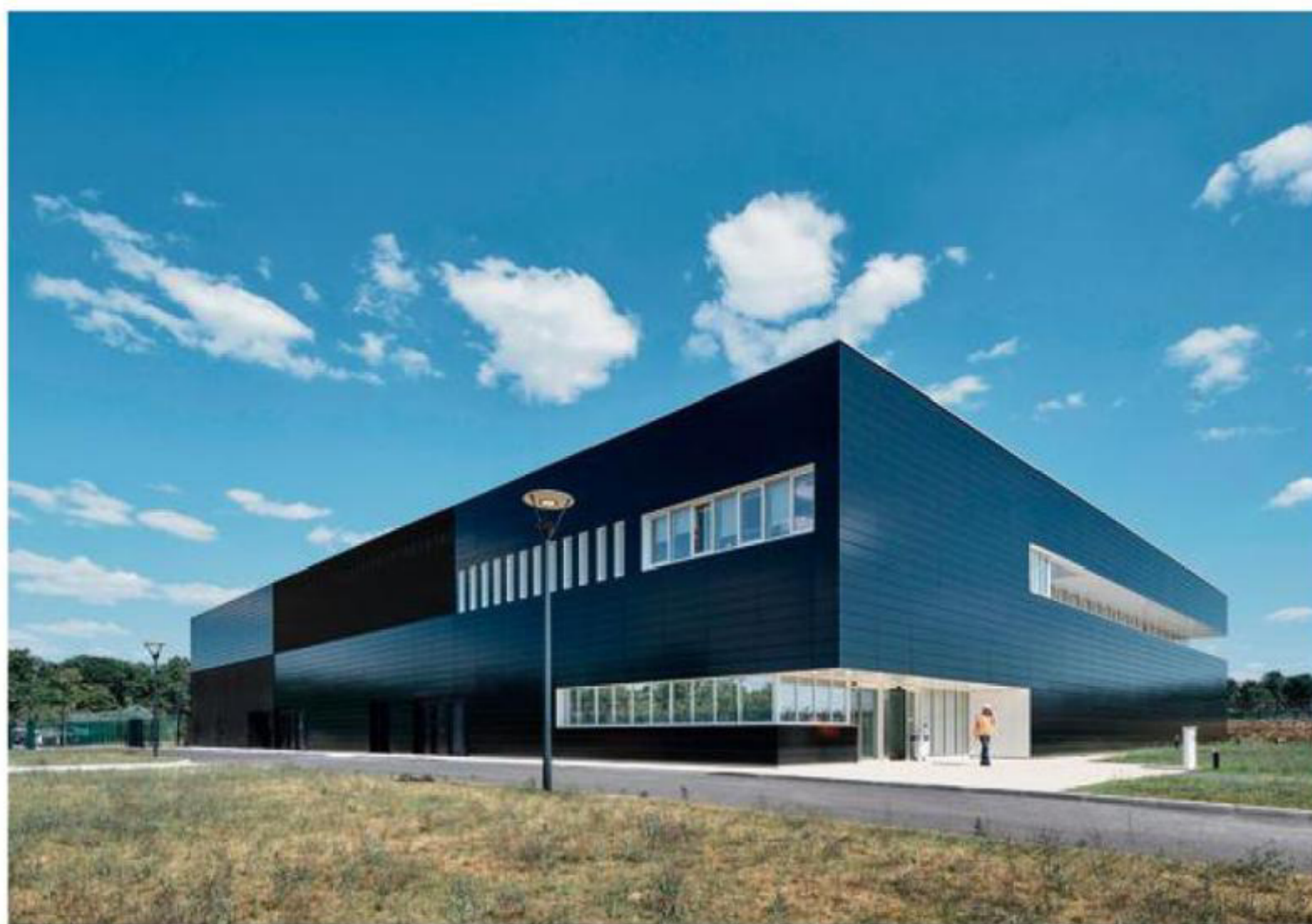
Vue du data center Galileo-Euspa, au Camp des Loges, à Saint-Germain-en-Laye (Yvelines). EPAILLARD + MACHADO
