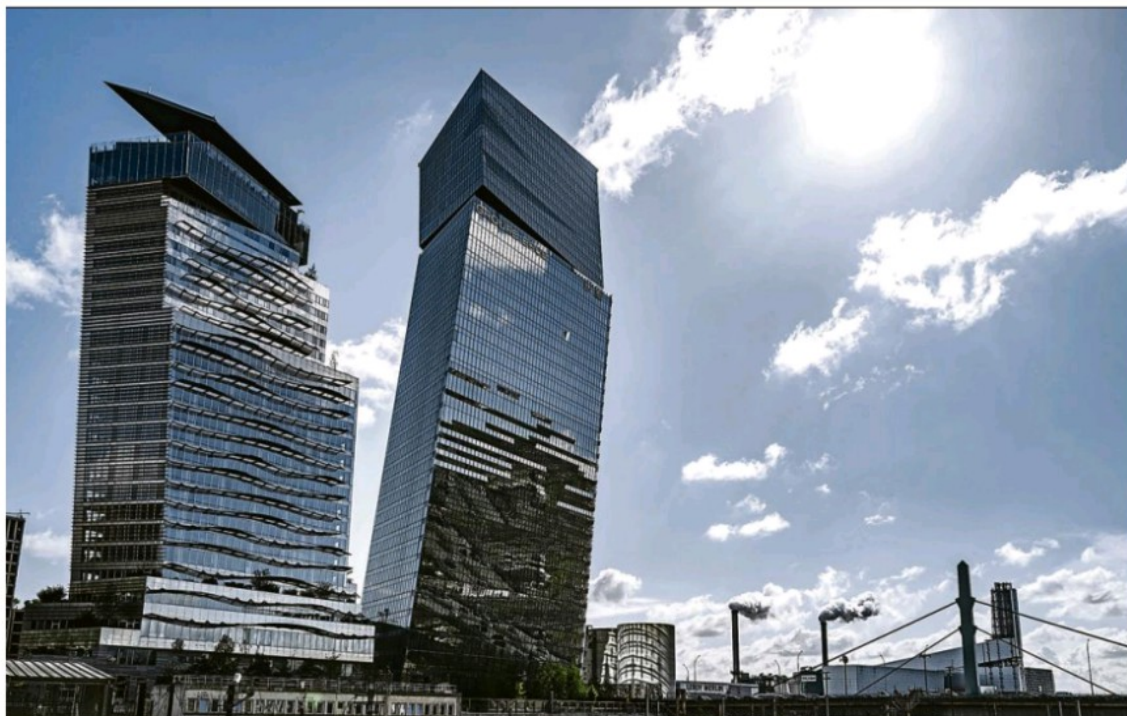
Les tours Duo, de l'architecte Jean Nouvel, abritent le groupe BPCE. Photo Xavier Popy/RÉA
