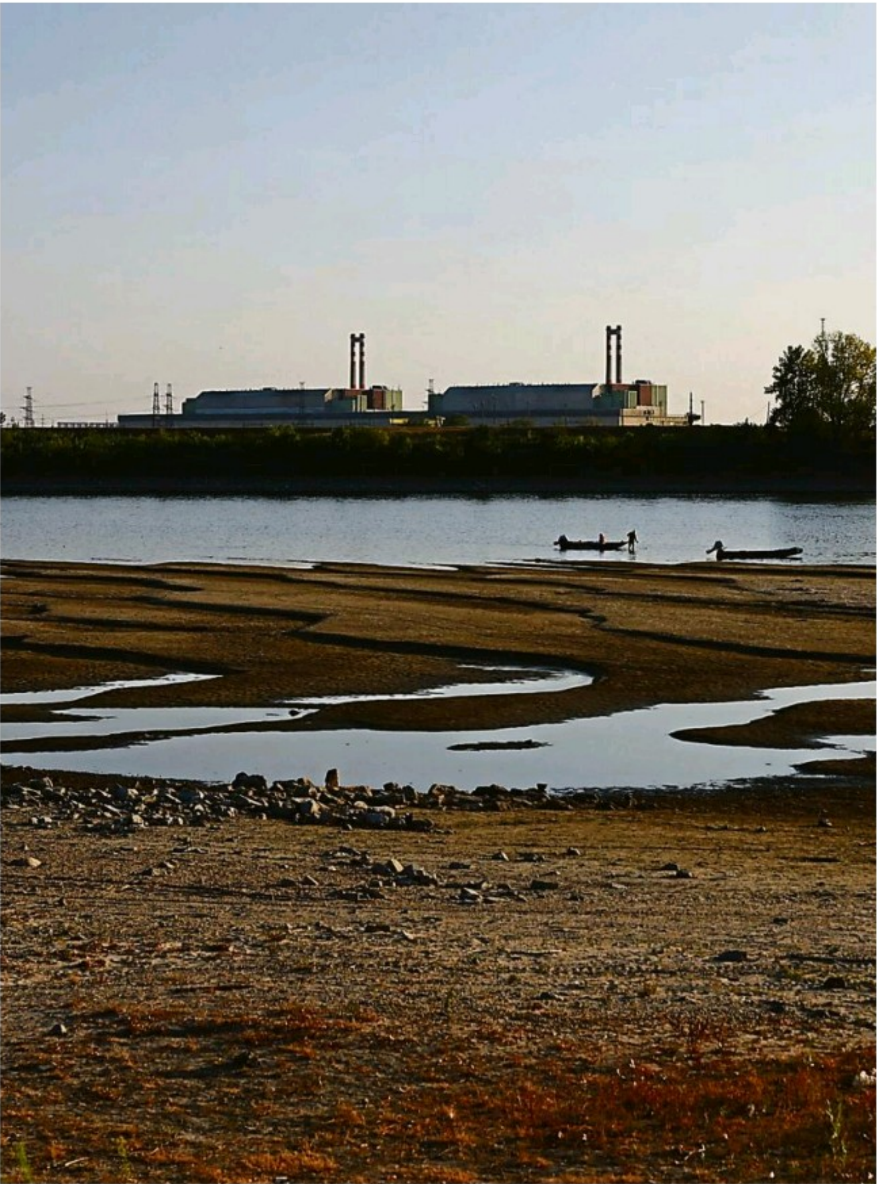
L'un des deux réacteurs nucléaires de la centrale de Cernavoda, refroidis par le fleuve, a été mis à l'arrêt en début de semaine passée. Photo Bernadett Szabo/Reuters
